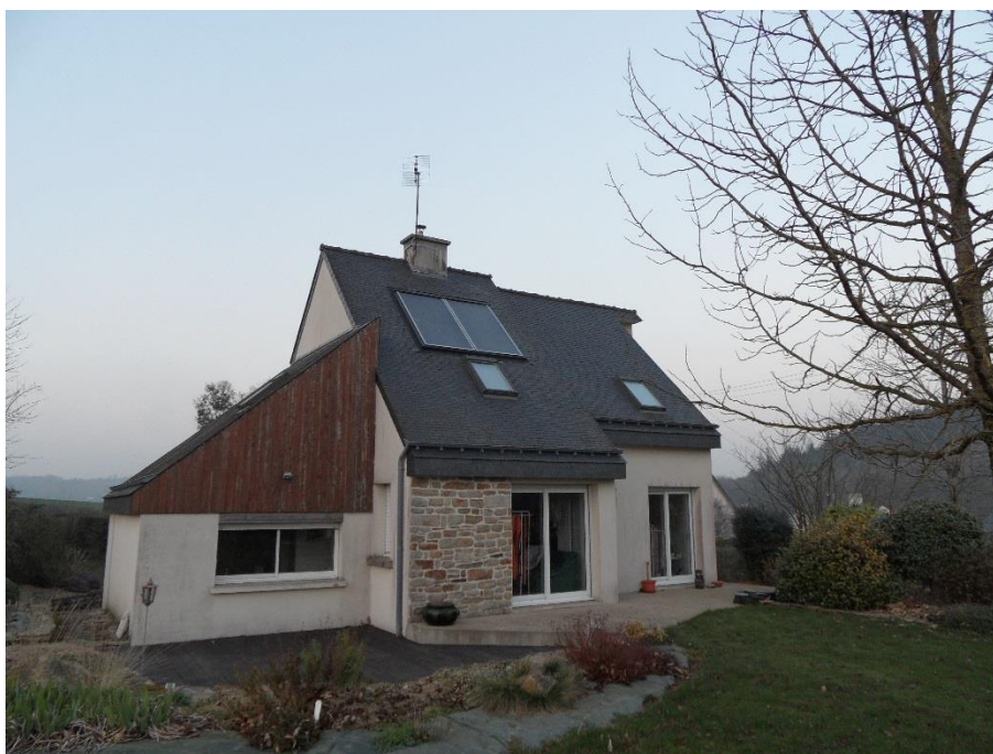
Deux panneaux solaires thermiques posés en intégration ardoise pour la production d'eau chaude sanitaire
