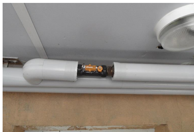
L'installation est composée d'un groupe de panneaux de 60 m 2 et un autre de 40m 2 , afin d'équilibrer les flux, des vannes d'équilibrage solaire sont posées sur chaque circuit
