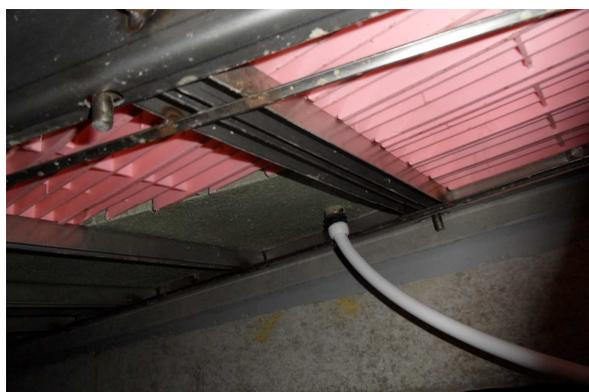
Raccordement des plaques chauffantes avec raccords en matière de synthèse
