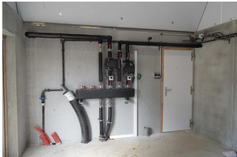
Sous station porcherie, répartiteur 3 circuits avec 2 départs motorisés (PS et Maternité) et une attente pour l'engraissement
