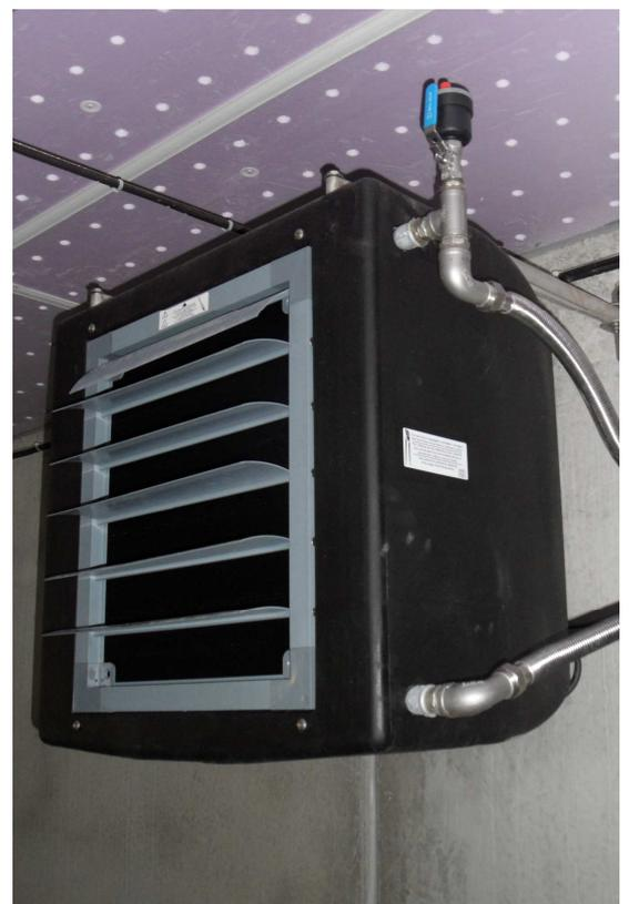
Aérotherme eau chaude avec raccords inox, flexibles tout inox, purgeur plastique
