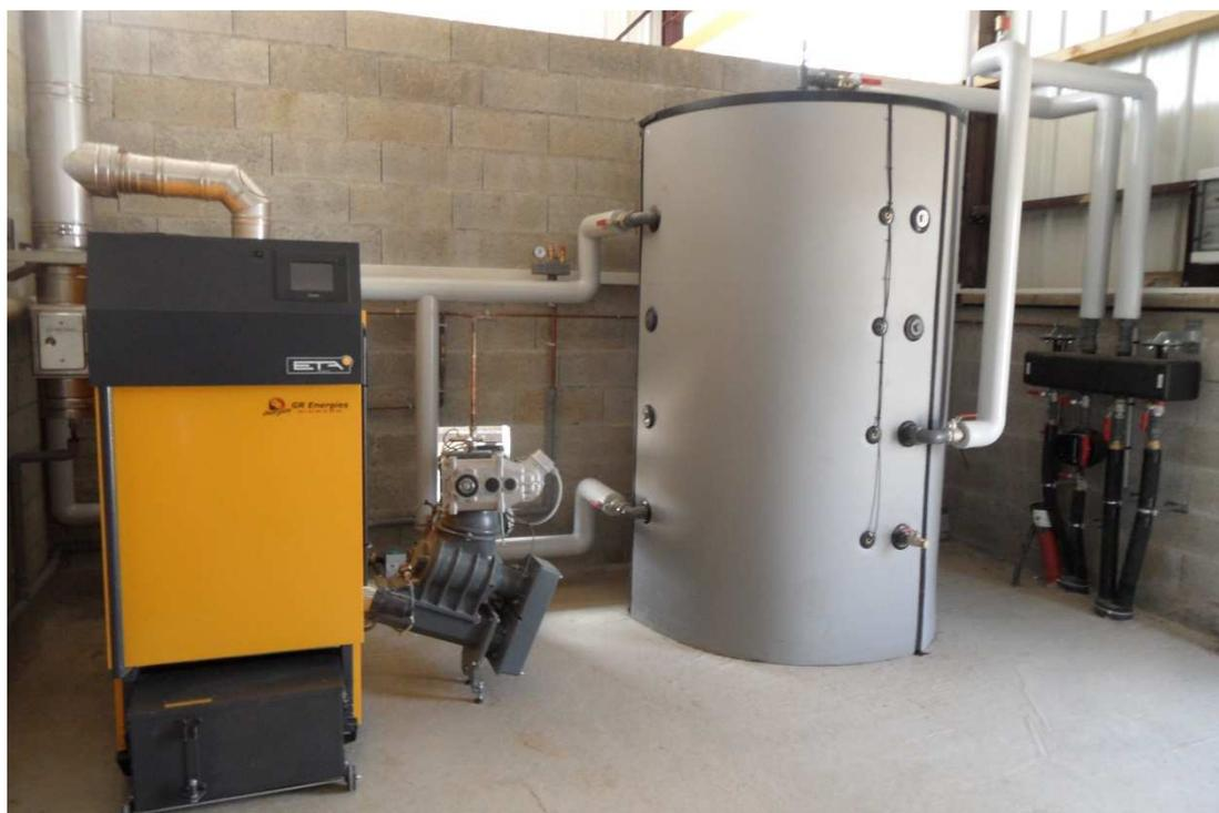
Chaudière **ETA Hack 90** à plaquettes de bois déchiqueté G50 raccordée sur ballon tampon de 2000 litres. Isolation de l'ensemble chaufferie par coquille de laine de roche et revêtement pvc. Répartiteur de chauffage 2 circuit, un départ vers l'élevage et un départ vers une maison d'habitation. Installation prévue pour le chauffage de :
