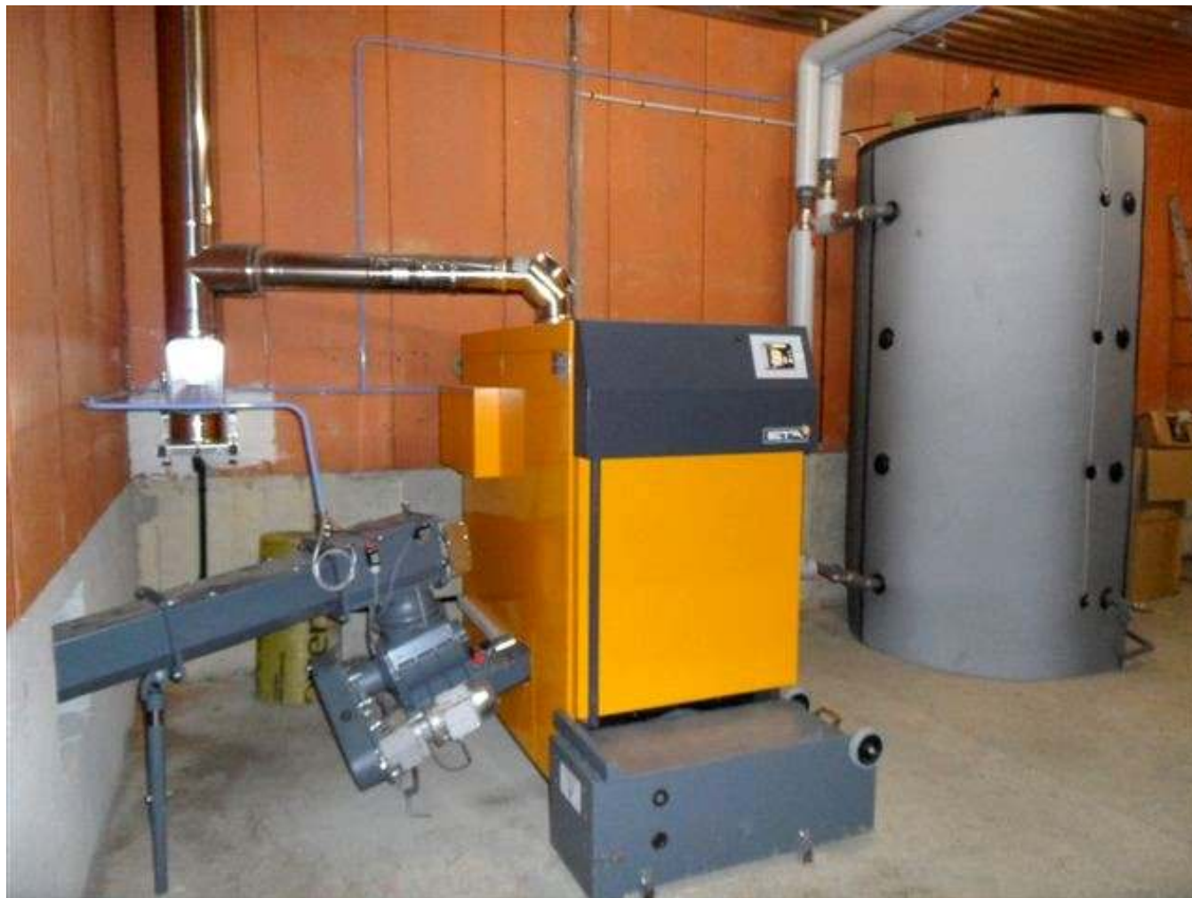
Chaudière ETA Hack de 130 Kw à plaquettes bois déchiqueté G50
